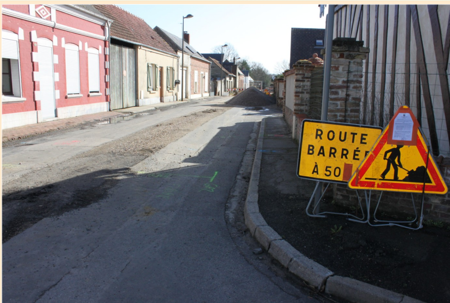
Les déviations évolueront au fur et à mesure des travaux.
