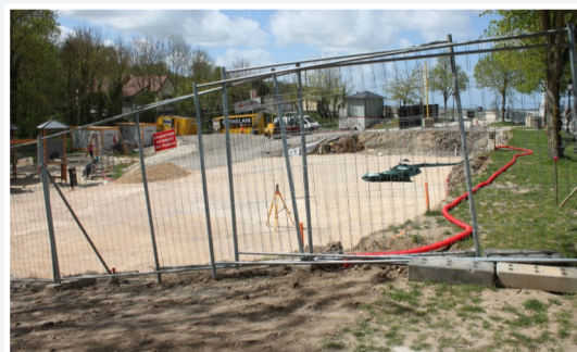
Le chantier de la future base des sports de nature, au bout du quai Jeanne d'Arc.
